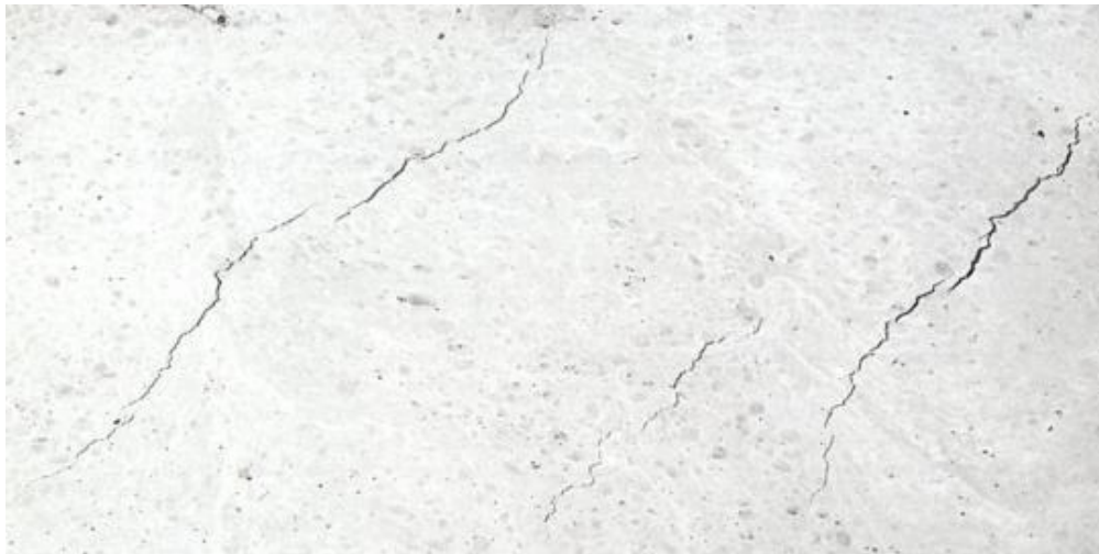
Figuur 7.9 Plastische krimpscheuren.
